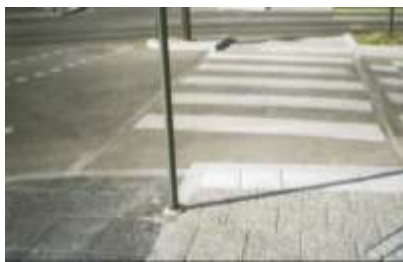
Рисунок 24– Пример выполнения пандусов по краю пешеходного перехода
