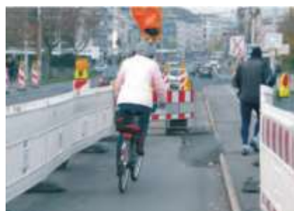
Рисунок 59– Пример обустройства короткого пандуса на временном пешеходном пути
