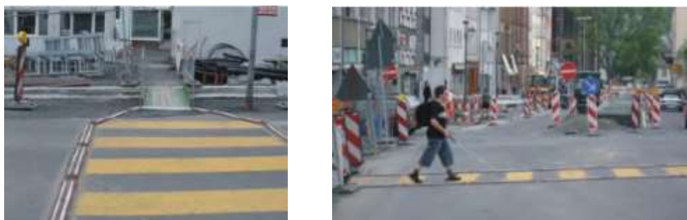
Рисунок 61– Пример обустройства временного пешеходного перехода
